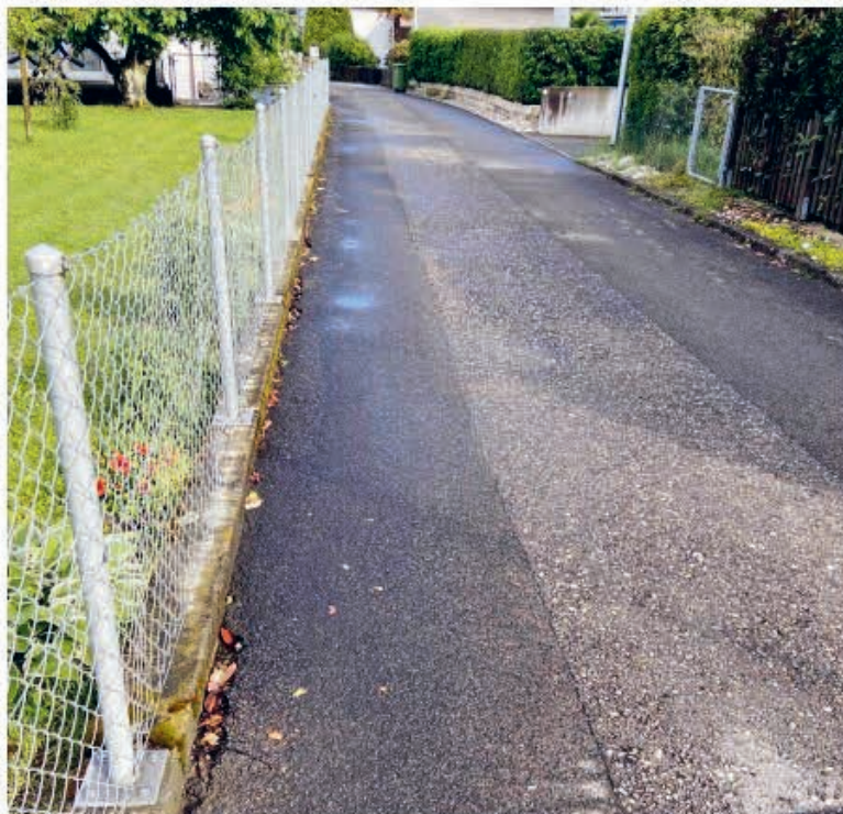
Abbildung 1: IST-Zustand Foto Birkenweg (12.06.2024)
