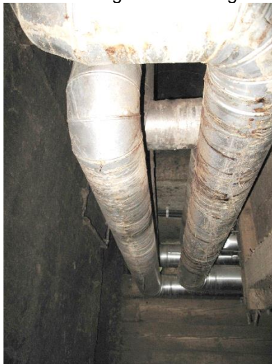
Leitungseintritt in den Steigschacht
